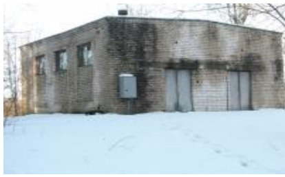
KSS- notekūdeņu pārsūkņēšanas stacija
