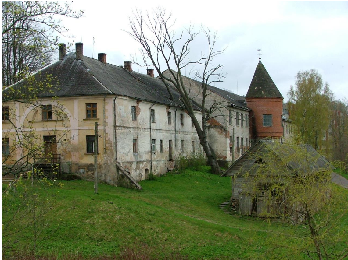
Kazdangas muižas ēka pirms rekonstrukcijas
