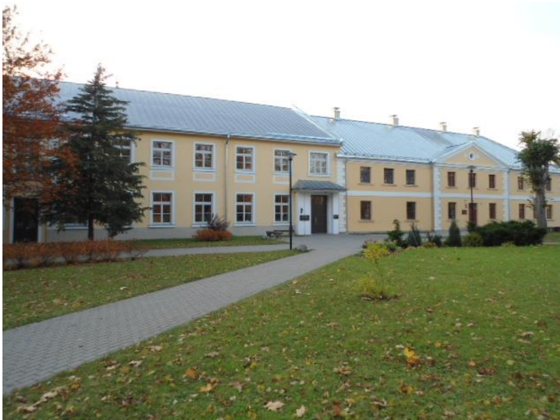
Kazdangas muižas ēka pēc rekonstrukcijas
